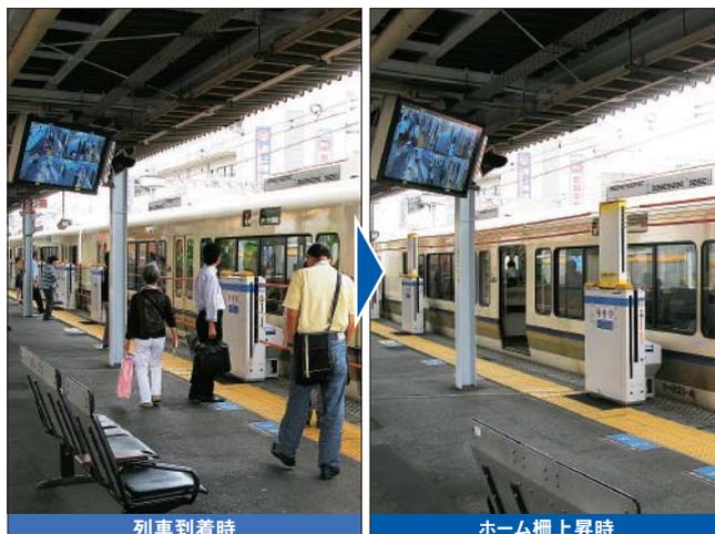
▲ホームの屋根に吊り下げられた「車掌用ホームモニタ」(写真左上)。ハウジングなどが不要のため、コンパクトなサイズとなり、利用客の頭上高を十分に確保。圧迫感なく設置されている。
