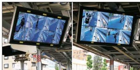
◀「車掌用ホームモニタ」を列車の停止位置に合わせて設置。設置位置によって、12両分の映像を表示する6分割表示(左写真)と、8両分を表示する4分割(右写真)を使い分けている。※2015年2月現在。
