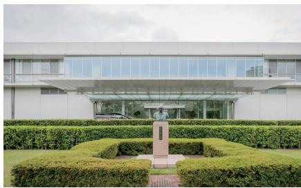
株式会社ブリヂストン様 久留米工場 第1工場
