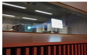
▲既存の投写室に設置
