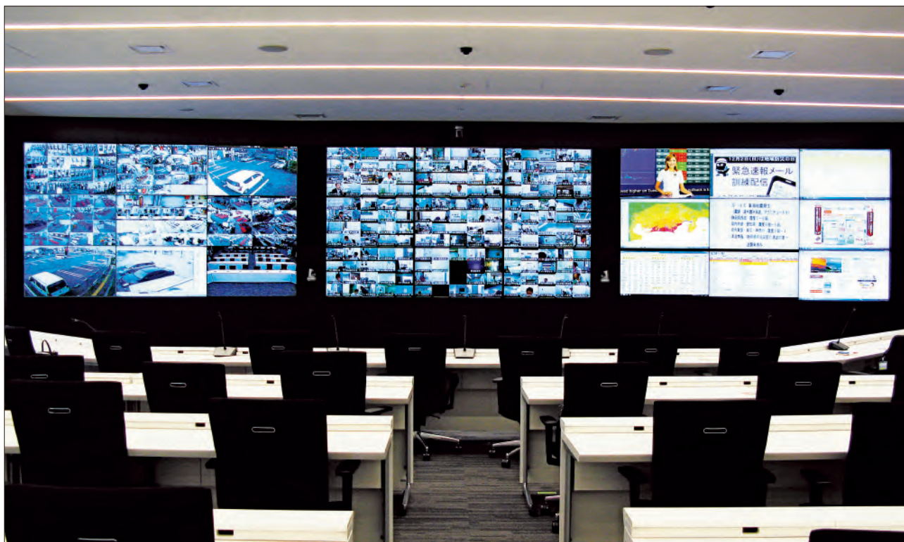
▲一度に数多くの情報を見通すことができる、55V型液晶ディスプレイ×27台で構築されたマルチスクリーンシステム。
