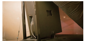
他のスピーカー同様、プロセニアムサイドスピーカーも正確な位置調整(高さ、向き)を施している
