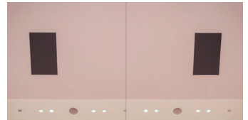
プロセニアム上部スピーカーは38cm 2ウェイのWS-HP400を4台設置
