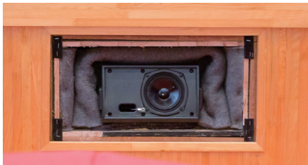
4台のステージフロントスピーカー、ステージフロントスピーカーには12cmコーンWS-M10T-Kを使用
