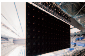
▲メインアリーナ妻側の大型映像表示装置を背面から見た様子。新開発の暴露型SMDを採用
