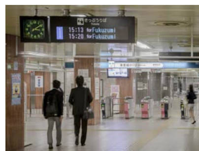
コンコース階に設置された旅客案内表示器
