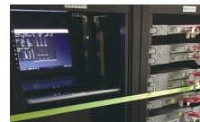
▲制御室内のラックには予兆監視ソフトウェアを搭載したパソコンを設置
