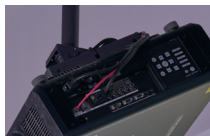
▲施設内のプロジェクターをLANケーブルでネットワーク
