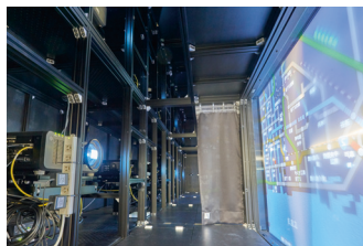
▲既設プロジェクターのミラー反射式の投写からPT-RZ771JLBでの直接投写に改修
