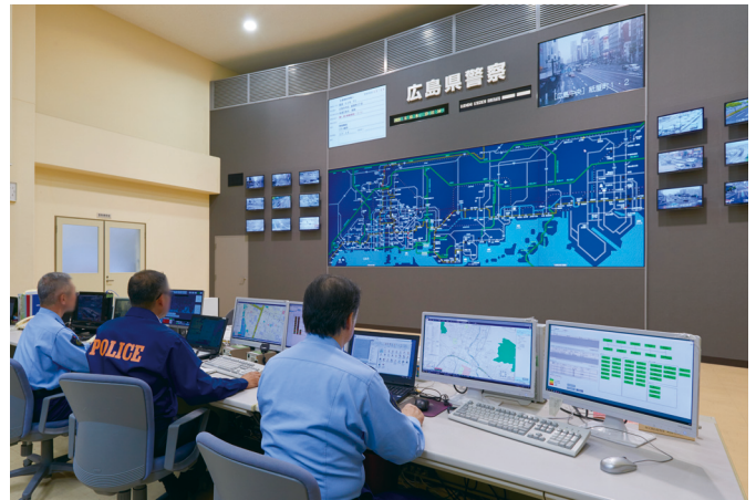
▲管制官の目の疲れを考慮した明るさで表示。輝度を落とすことで、より長時間の安定運用が可能に マルチスクリーン上部の2面の表示装置もPT-RZ771JLBにリプレイス
