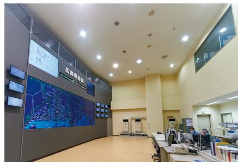
▲管制官の目の疲れを考慮した明るさで表示。輝度を落とすことで、より長時間の安定運用が可能に マルチスクリーン上部の2面の表示装置もPT-RZ771JLBにリプレイス
