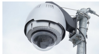
千鳥津波避難所屋上に設置された防災カメラ
