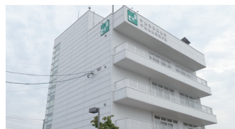
防災カメラが設置された千鳥津波避難所。民間も含め11箇所に設置
