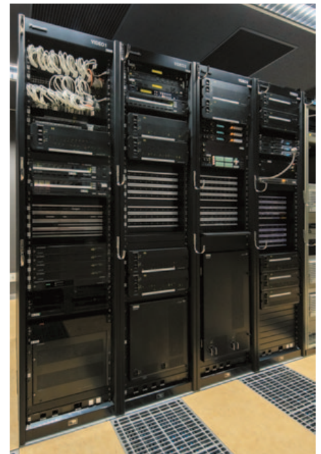
▲スイッチャー本体、ルーター、ペリフェラルが収まったラック室。ルーターは、12G-SDI対応ルーティングスイッチャーAV-WM8400を160入力×100出力で採用
