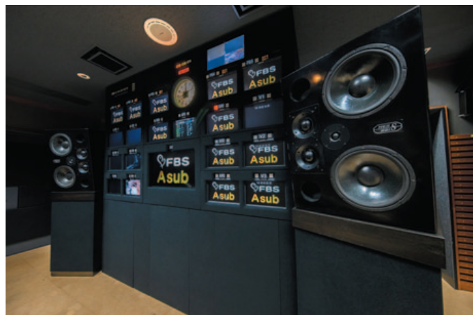
▲ 音の反響を抑えるために音声モニター棚は木材で製作し、パネル部分はメッシュの布素材にした
