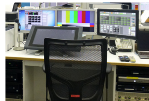
▲操作卓では大画面のマルチスクリーンとの連動により情報を運用
