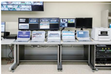
▲メインの操作室である「施設課」。ノートパソコン5台を使用してタイトルやスコアの挿入、画面レイアウトの選択、リボンボードの各種設定を行う
