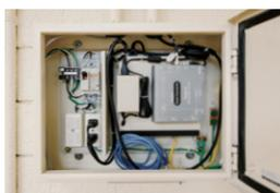
▲アリーナ内4か所に用意された信号端子盤。ノートパソコンを接続して競技中に制御システムの遠隔操作が可能
