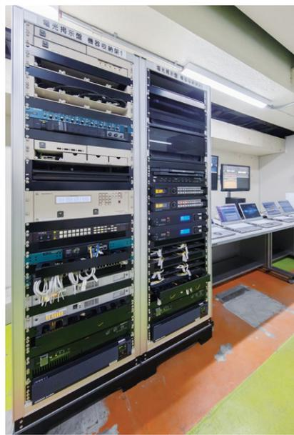
▲リボンボードの制御システムが集約された「電気準備室」のラック架。奥には、表示素材仕込み用のノートパソコンが置かれている
