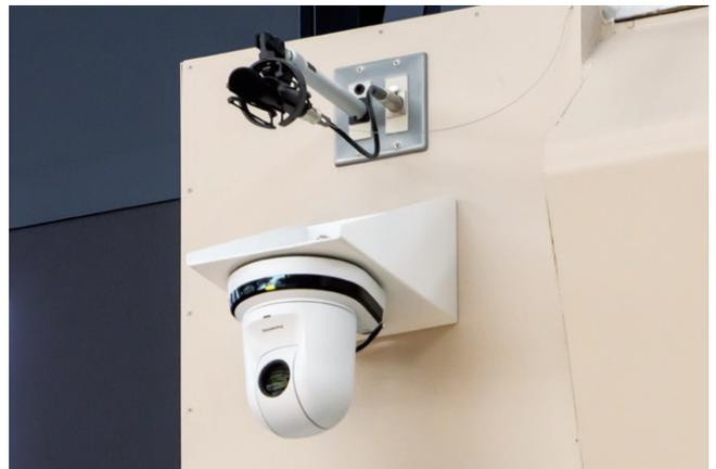
▲リボンボード横に設置されたHDインテグレートドカメラAW-HE70SW9。カメラの上には集音マイクが設置されている
