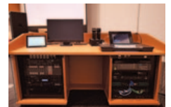
▲ホール袖卓にはWR-DX100やリモートコントロール用タブレット端末を用意
