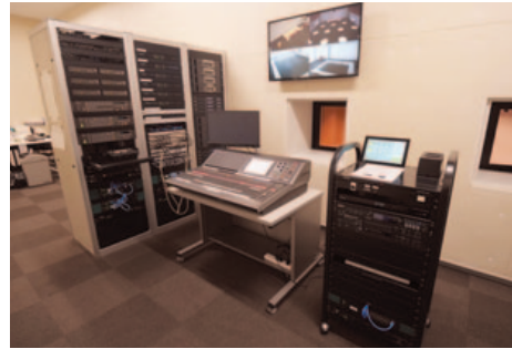
▲音響調整室のWR-DX400とWP-DM900シリーズなどが収納されたラック架
