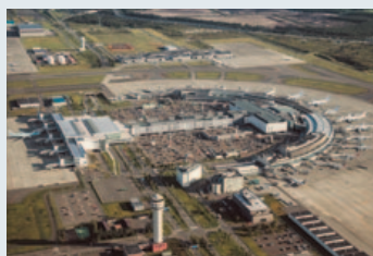
▲北海道の空の玄関口、新千歳空港ターミナルビル
