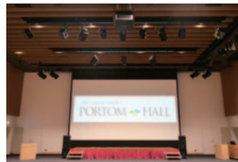
▲天井に取り付けられたPT-RQ13KJと舞台の左右にそれぞれ設置されたメインスピーカーWS-HP400とサブウーハーWS-HP450
