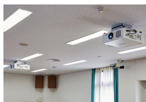
▲2系統のプロジェクターに信号伝送できるDIGITAL LINK機能で配線をシンプル化
