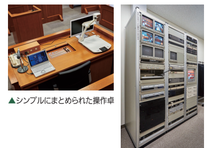
▲法廷内のカメラ映像をモニタリングし、プロジェクターに出画できる制御室のシステム
