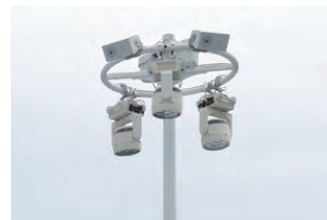
▲パビリオン屋外では照明用のホールに全天候型スピーカーが設置された
