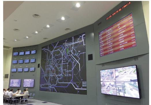
▲管制センターは吹き抜けの高い天井になっている。一番低輝度となる「ロングライフ3」モードで運用されているが、明るい室内でも十分に鮮明な表示を実現。また、広視野角で室内の端からでも各種情報をハッキリ確認することができる。
