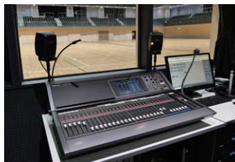
▲デジタルミキサーWR-DX400(左)とデジタルアンプ調整用のソフトウェア操作画面(右)
