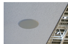
▲観客席の天井に設置された天井埋込スピーカーWS-A44
