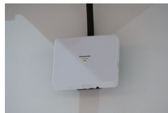
▲ボルダリング室に設置された1.9 GHz帯デジタルワイヤレスマイクシステムWX-SR200Aシリーズのワイヤレスアンテナ
