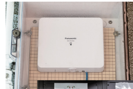
◀ 施設内の4か所に設置されたワイヤレスアンテナ WX-SA250A
