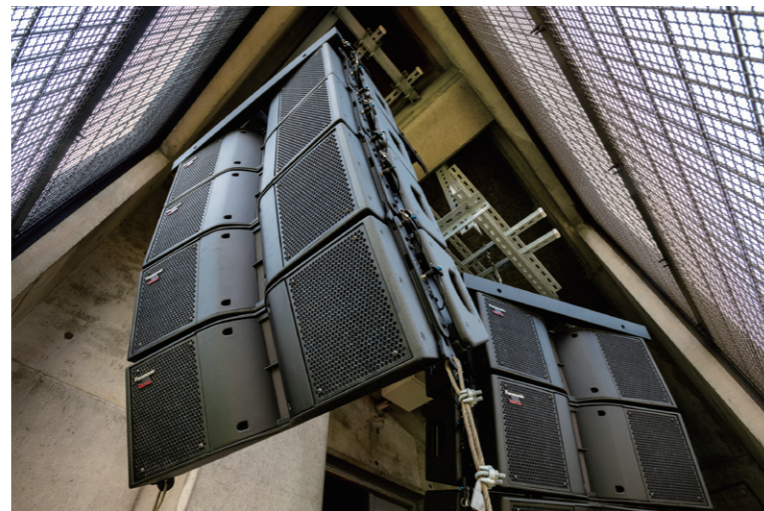
▲ バックスクリーン内に格納されたラインアレイスピーカーWS-LA500AWP
