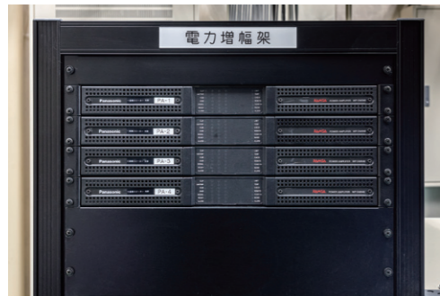
▲ 4台のデジタルパワーアンプWP-DM948はWS-LA500AWPと同じくバックスクリーン内に設置されている
