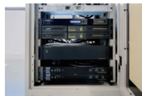
▲音響ラックには、PASDで処理した計算値を自動で流し込むことができるRAMSAデジタルパワーアンプWP-DM912を2台格納
