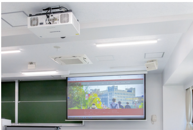
▲「中教室」の液晶レーザープロジェクターPT-MZ10KJL。蛍光灯を点けていても見やすい明るさが確保できると好評
