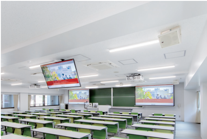
▲「中教室」の様子。天井の前後左右に計4台のRAMSAニアフィールドスピーカーシリーズ 16 cm 2ウェイスピーカーWS-NF055が設置されている
