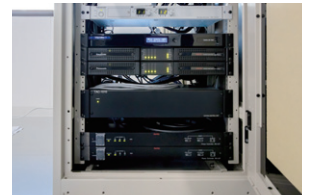
▲音響ラックには、PASDで処理した計算値を自動で流し込むことができるRAMSAデジタルパワーアンプWP-DM912を2台格納
