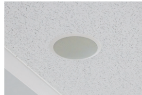
▲教室の中央エリアをカバーする補助スピーカーRAMSAニアフィールドスピーカー(天井埋込)WS-AC066
