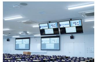
▲1チップDLP®レーザープロジェクターPT-RZ690JLWを2台と55型フルハイビジョン液晶ディスプレイTH-55SF2Jが6台設置された実習室
