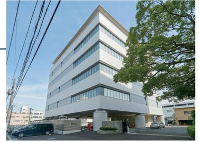
▲震度7クラスの地震にも耐え得る免震構造の「広島ガス防災センタービル」
