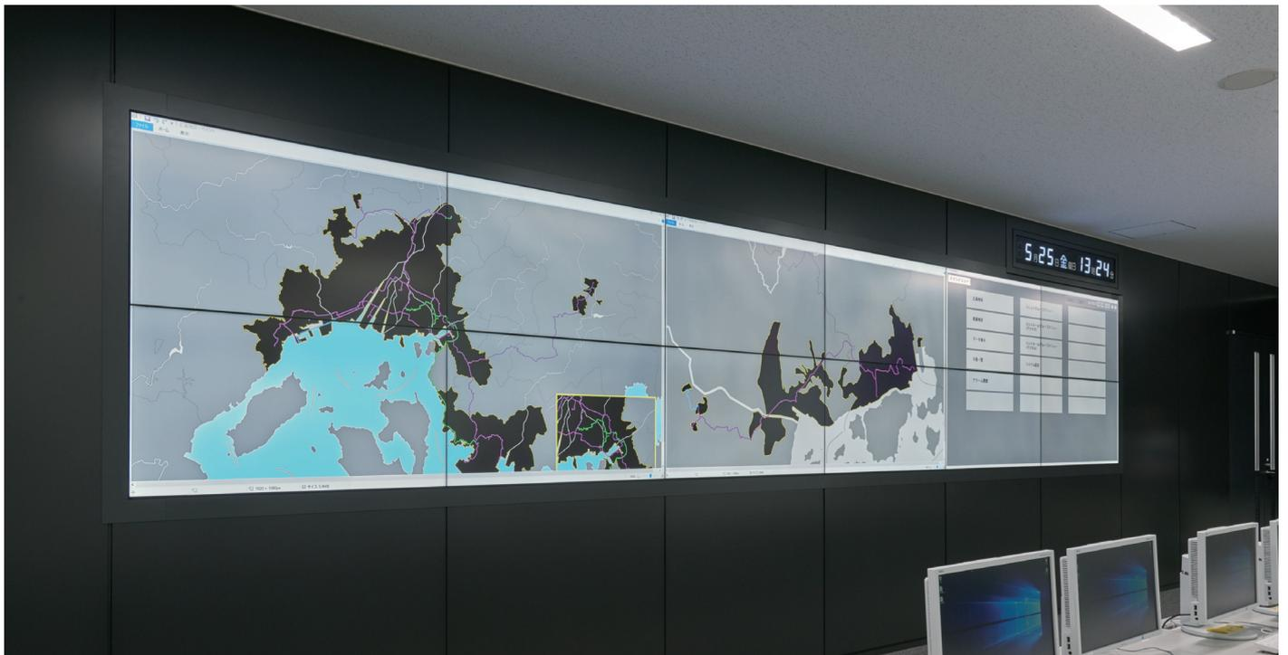
▲3階の「保安指令センター」に新設された、縦2面×横6面の12面大型マルチビジョンシステム。都市ガスの圧力・輸送状況等が、24時間365日体制で監視される
