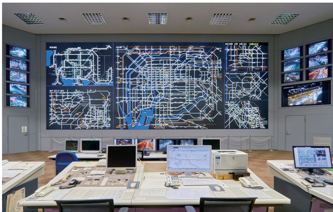
▲横12.4 m縦4.85 mの大画面を構成する、72型×40面によるマルチビジョンが鮮明に交通情報を映し出す
