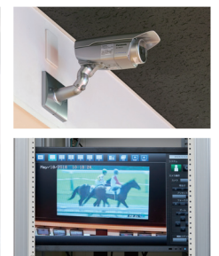
▲新たに監視カメラWV-SPW310も設置。8階の大型映像操作室でスクリーンの様子が確認されている
