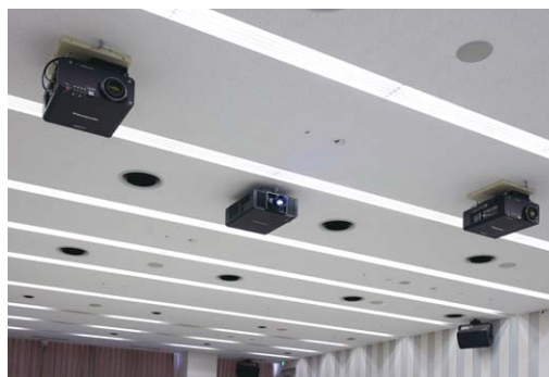
▲日本工学院専門学校の階段教室ではPT-RZ21KJ(中央)を新設。既設の当社製ランプ光源プロジェクター(両端)は左右2画面投写の際に活用されている
