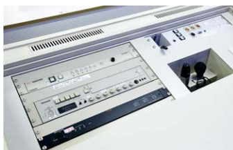
▲操作卓は、プロジェクターやスピーカー、マイクなどの操作盤が一体となり、アナログ入力も含めた多様な入力端子が設置されている
