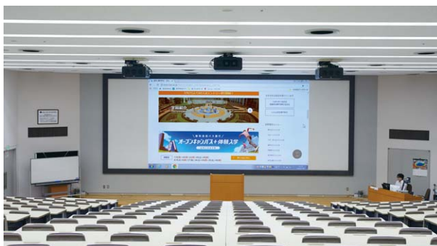
▲日本工学院専門学校の階段教室ではPT-RZ21KJ(中央)を新設。既設の当社製ランプ光源プロジェクター(両端)は左右2画面投写の際に活用されている
