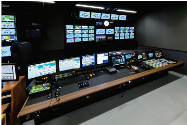
▲報道サブでは向かって右手にライブスイッチャーAV-HS7300を、PD/TK卓との間にOTC卓を配置した
