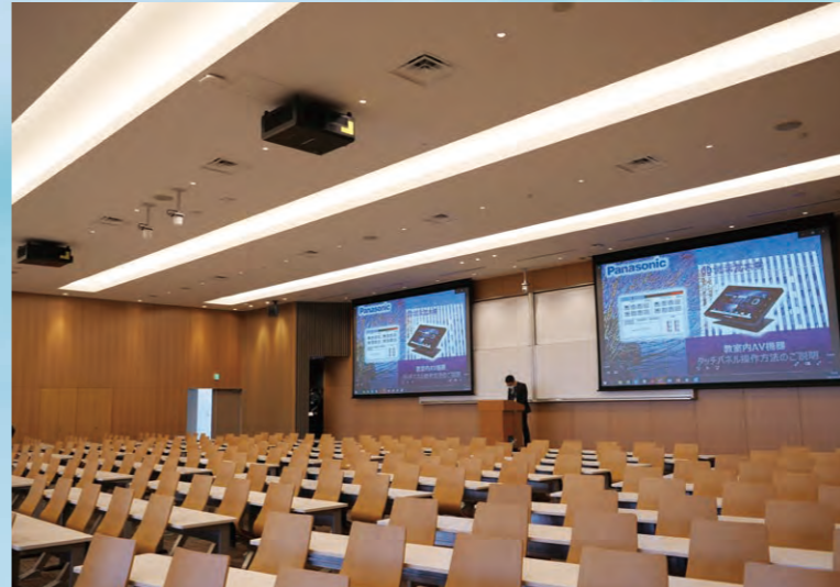
▲ブラックスクリーンを左右2面設置し、3チップDLP®レーザープロジェクターPT-RZ21KJを使って投写する大講義室。音響にもこだわり、高音質なRAMSAアレイスピーカーと天井スピーカーを導入している
