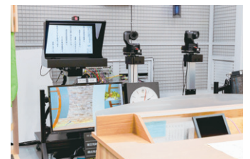
▲L2スタジオのブロンターカメラ。映し出された原稿の後ろにAW-UE150が設置されている。手元の原稿は天井に設置したAW-HE70で撮影
