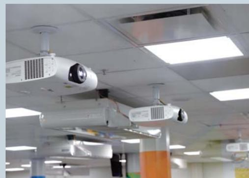
デジタルリンクスイッチャー/デジタルインターフェイスボックスを活用し、HDBaseT™準拠のプロジェクターにLANケーブル1本で高画質な映像を長距離伝送。オペレーションルームから離れたバックヤードからの映像伝送が容易に。
