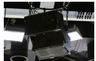
▲アリーナ天井に39台設置されたスピーカーWS-HP400
