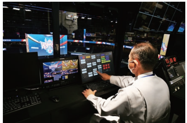
▲センタービジョンやリボンビジョンの他、会場内すべての映像表示システムがタッチパネルで簡単に切り替え可能な操作端末
