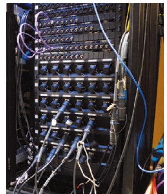
▲スタジオカメラはパッチ盤の抜挿により、3つのホールを可搬式で運用可能
