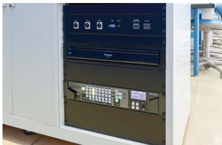
▲操作卓下に入力端子やスイッチャーがすっきりとまとめられている。スイッチャーはローランド社製 ※パナソニック システムソリューションズ ジャパン株式会社専売モデル
