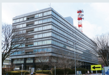
▲ 国土交通省 中部地方整備局様が入居する名古屋合同庁舎第2号館
