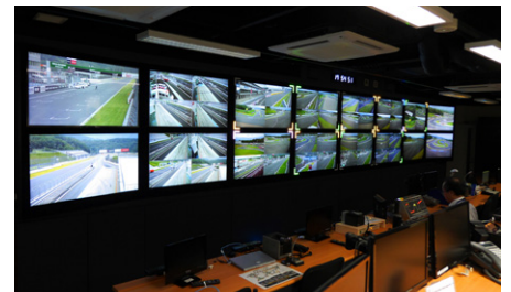
管制室の30面以上あるモニターの枠に設置したLEDパネルでフラッグ掲示状況を瞬時に判断可能
