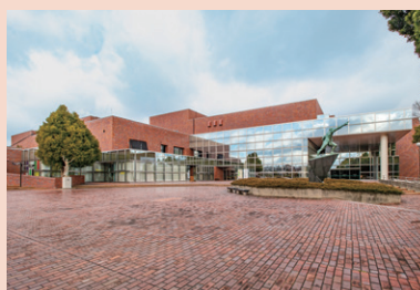
▲豊田市民文化会館様の外観
