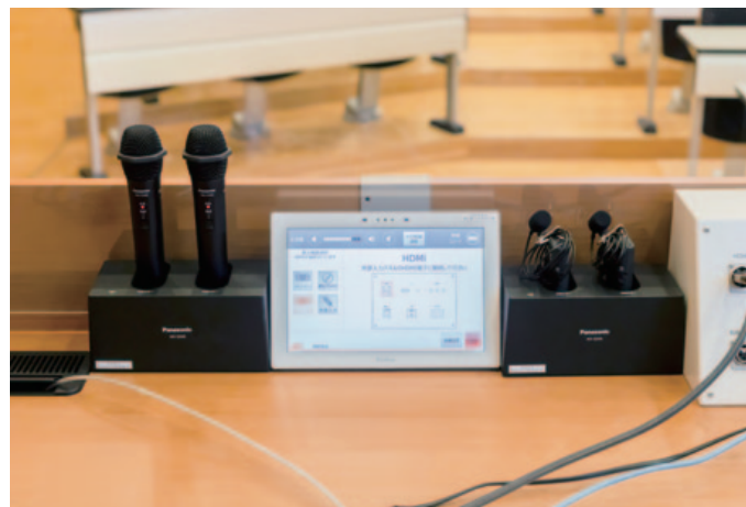
▲ 184席ある視聴覚室の教卓に設置された1.9 GHz帯デジタルワイヤレスマイクシステムとワンタッチコントロールパネル
