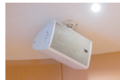
▲ 視聴覚室のメインスピーカーRAMSA30cm2ウェイスピーカーWS-M200-W
