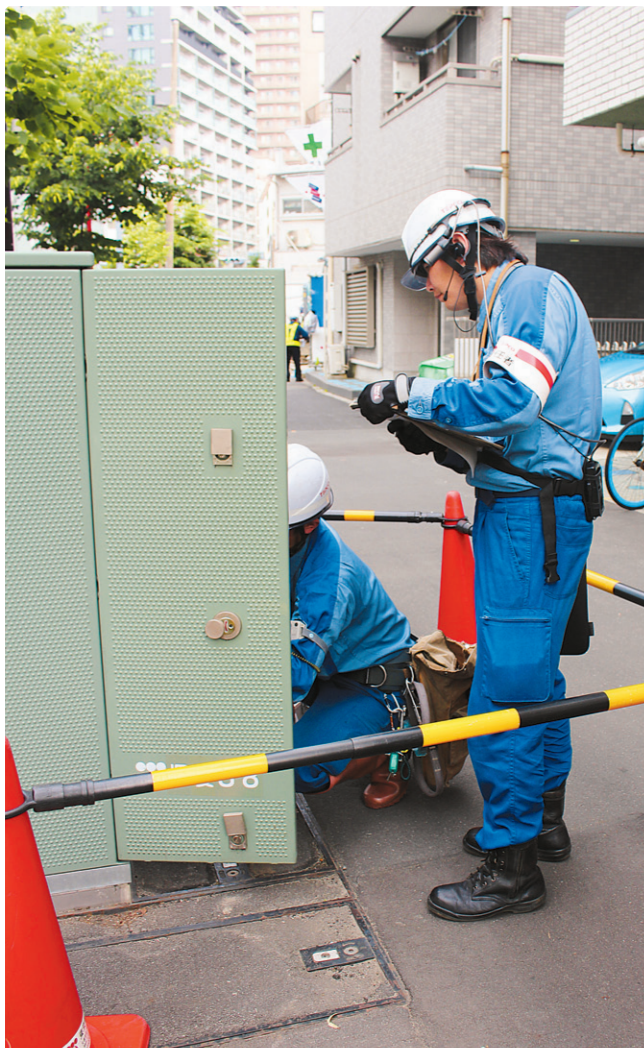
配電箱の中をウェアラブルカメラで撮影しながら確認
