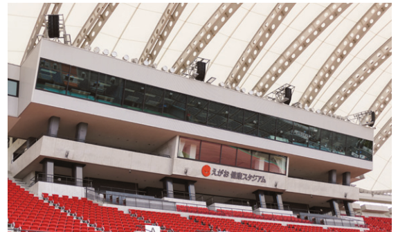
ラインアレイスピーカーWS-LA500AWPをメインスタンド上部に4式設置
