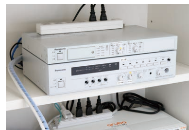
▲ アクティブラーニング室、ICT室に設置された1.9GHz帯デジタルワイヤレスマイクシステム。安定した通信で、円滑な授業進行に貢献。
