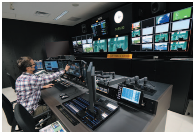
▲ニュースサブの様子。モニターはアームで動かせるため、アーチ状にモニターを並べることでワンマンオペレーションがしやすい設計になっている
