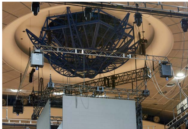
▲昇降式トラスの各隅に4台設置されたPT-DZ21K2J。重量制限に耐えうる軽量ボディもご採用いただいた理由のひとつ
