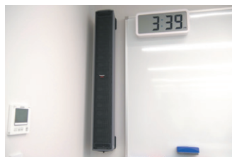
▲ 講義室に均一な拡声を行うラインアレイスピーカーWS-LA100
