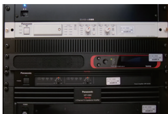
▲ 音質を明瞭にするプロセッサーなどが設置された教卓下のラック架
