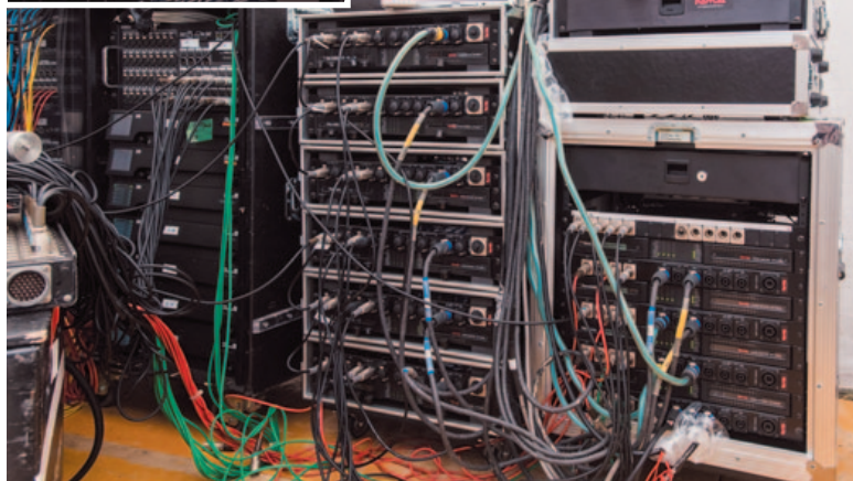
▲ デジタルパワーアンプWP-DM948。ラック左側がスピーカーに、右側はサブウーハーに接続
