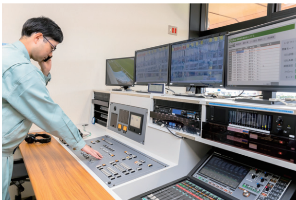
▲ 拡声パターンの切り替えは制御卓のスイッチからワンタッチで可能
