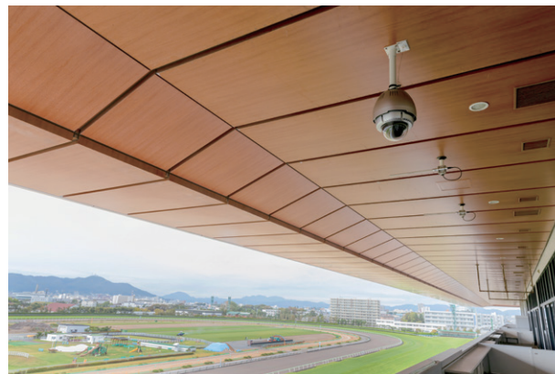
▲ 入場やファンファーレなどのタイミング確認用に導入されたリモートカメラ AW-HE70SK9 (屋外用ハウジングに格納)
