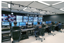
▲メインの操作卓2卓、サブの操作卓6卓で構成された放送センター。前方に全国の送出状況を全て表示する画面を配置
