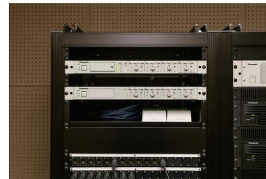
▲ 放送室の音響機器収納架に格納されたワイヤレス受信機WX-SR204A(4ch)、増設ワイヤレス受信機WX-SE200A(4ch)、同軸変換ユニットWX-SA002
