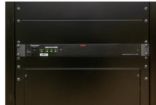
▲ 音響機器収納架の電源制御には電源制御ユニットWU-LP067が採用された
