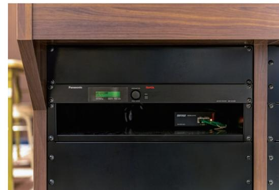
▲ AV操作卓に設置されたデジタルミキサーWR-DX200
