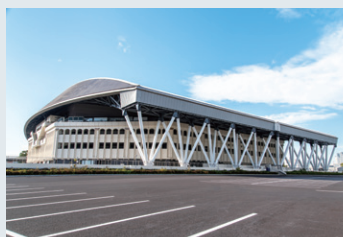
▲有明コロシアム外観。テニストーナメント中は屋根を開放している
