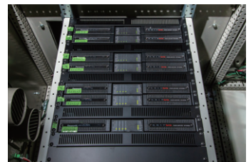
▲センタークラスターのすぐ近くに設置された16台のデジタルパワーアンプWP-DM912/DM948
