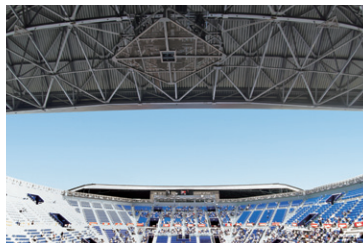
▲屋根開放時の様子。開閉に関わらず最適な音圧となるようプリセットで設定変更が可能。急な雨で屋根を閉めても音質を保てる大会主催者からも好評
