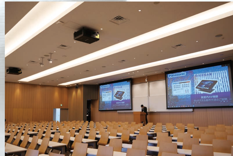
▲ブラックスクリーンを左右2面設置し、3チップDLP®レーザープロジェクターPT-RZ21KJを使って投写する大講義室。音響にもこだわり、高音質なRAMSAアレイスピーカーと天井スピーカーを導入している
