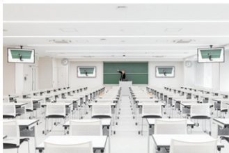
▲ TH-65EQ2JとTH-50EQ2Jが設置された801講義室。500 cd/miの映像表示により明るい教室でも見やすいと好評。板書時には天井のAW-UE40Wで黒板を撮影し表示する
