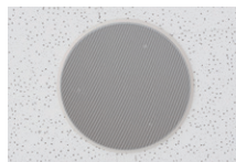
▲ 講義室と救命救急実習室へは音響拡声用として天井埋込スピーカーWS-A12Tを設置
